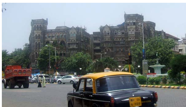
Kolonialbauten in Mumbai
